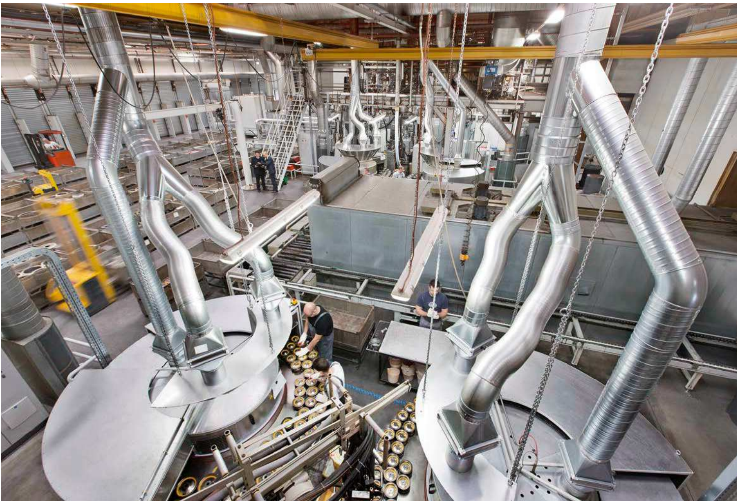
Werk 2/Prepolymerherstellung in Hamburg-Wilhelmsburg
